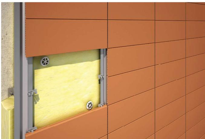
Détail partie courante ossature métallique
