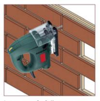
Les coupes à réaliser pour le calepinage de l'ensemble, s'effectuent facilement à l'aide d'une scie sauteuse et d'une disqueuse équipées de lames et de disques appropriés. Pour l'assemblage parfait des coupes et des panneaux, le mastic polyuréthane sera à disposer entre ces pièces.
